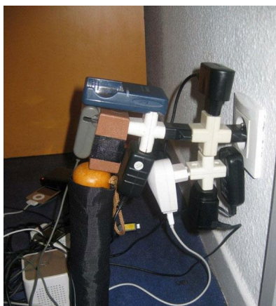
3. Kép Elektromos elosztók szabálytalan használata.
