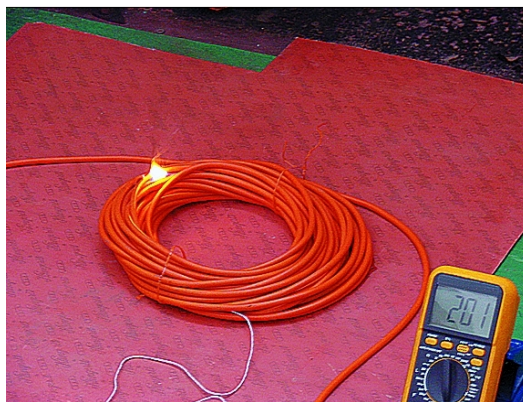
2. Kép Túlterhelt elektromos hosszabbító kábel túlmelegedése, meggyulladása.
